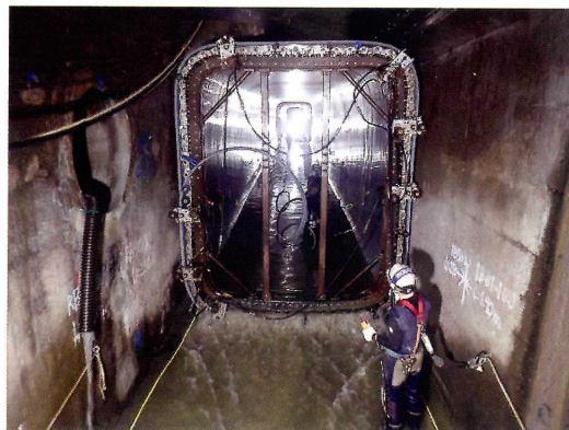
写真1 幹線内SPR施工状況
