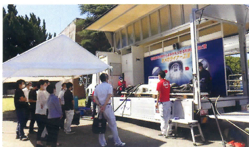
オメガライナー工法拡径デモ施工(米子市・内浜処理場)
