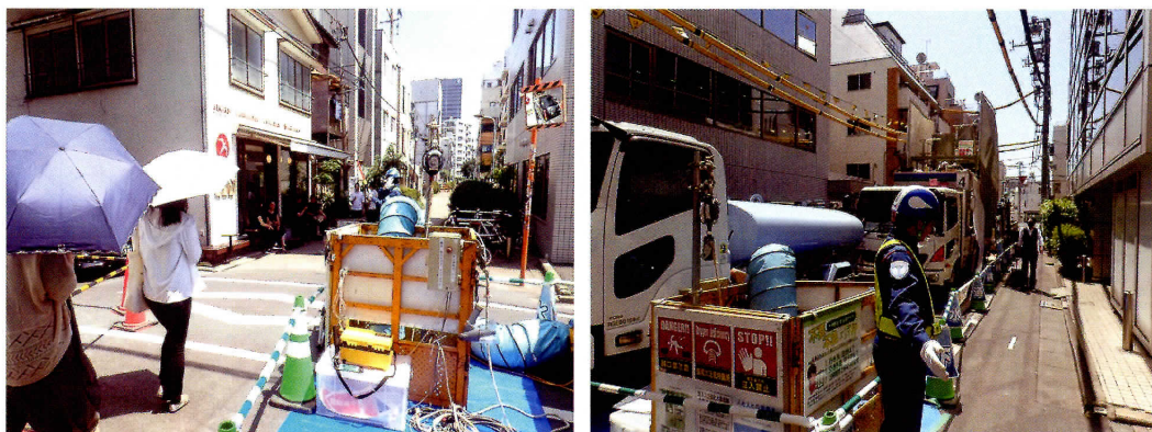
写真2 地上部作業帯および誘導状況
